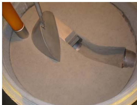
Fot. 2.22. Regulator wirowy zamontowany w studni z kinetą, odpływ z regulatora z dodatkowym króćcem pełniącym funkcję przelewu awaryjnego
