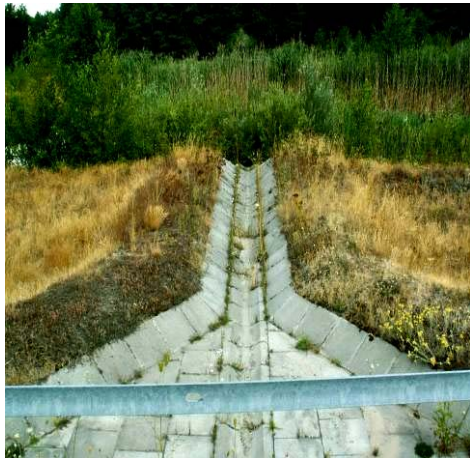
Fot. 2.7. Dopływ do stawu infiltracyjnego z roślinnością wodną - przykład dobrego rozwiązania, gdyby nie brak krat i osadnika przed zbiornikiem
