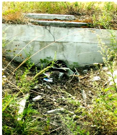
Fot. 2.2. Zatkany wlot do piaskownika i separatora
