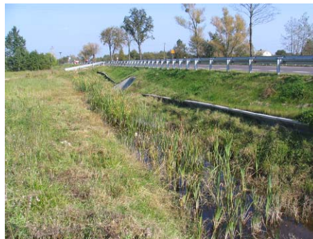
Fot. 2.12. Rów infiltracyjny - droga Lublin-Dorohusk
