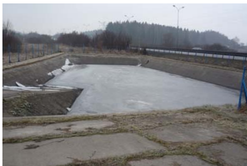
Fot. 2.18. Zbiornik retencyjno-sedymencyjny współpracujący z pompownią – obwodnica Trójmiasta, węzeł Barniewice
