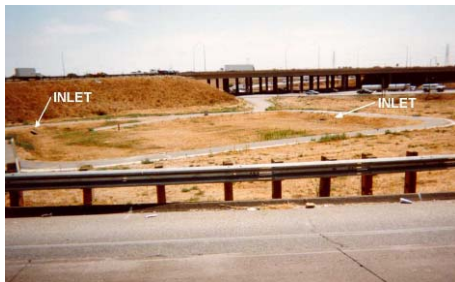
Fot. 2.9. Staw infiltracyjny suchy [39]
