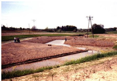
Fot. 2.11. Budowa stawu o rozszerzonej retencji z groblami filtracyjnymi – Biolkowo, woj. pomorskie
